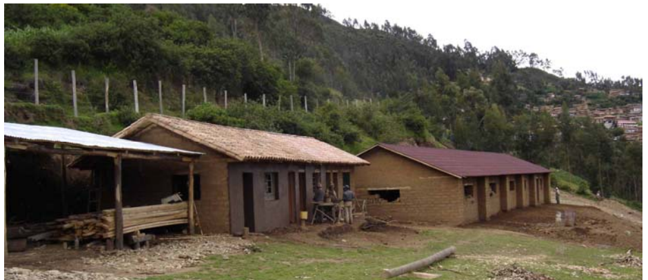
Villaggio degli anziani a Cotabambas (Perù) - lavori in corso
